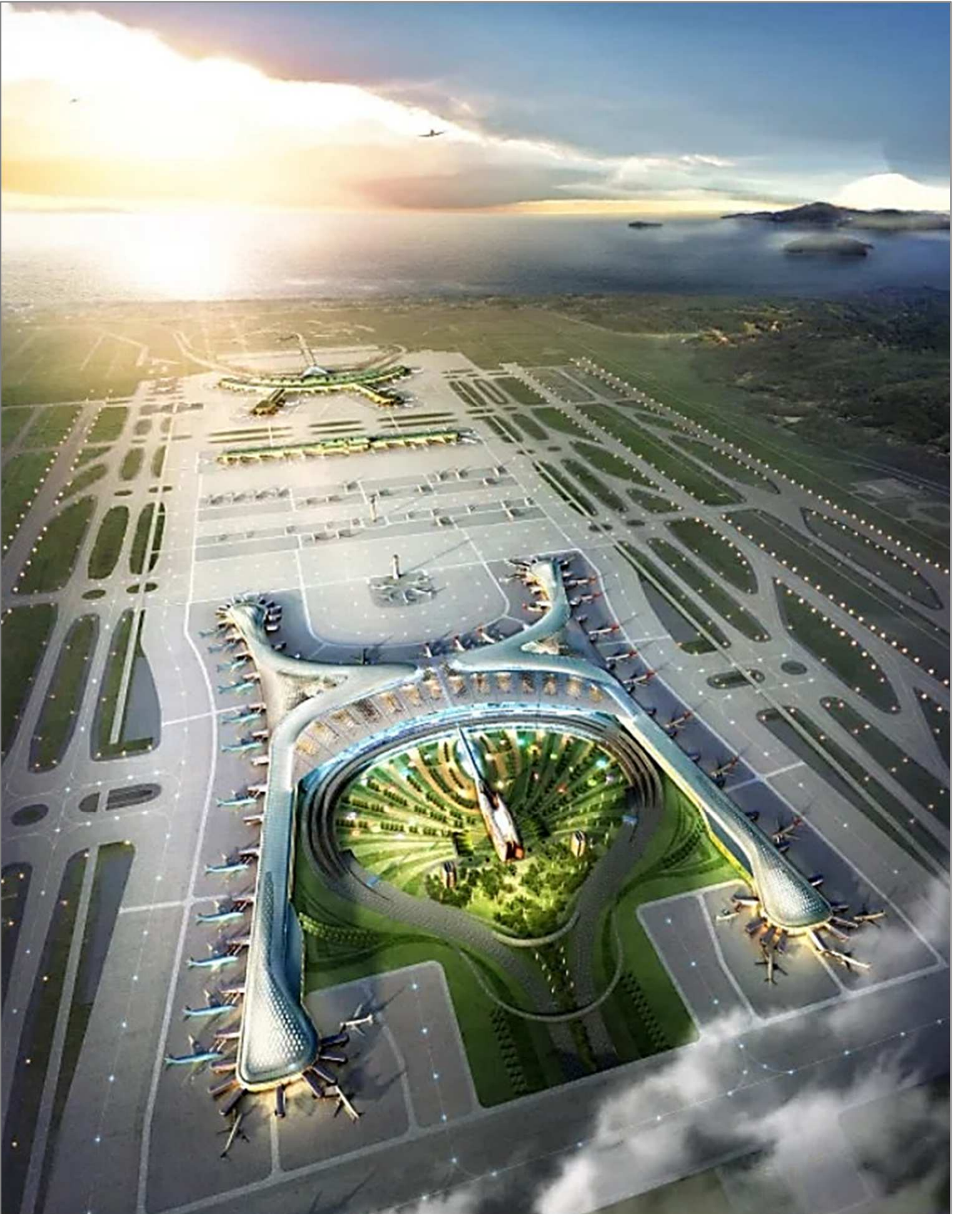
인천국제공항 제2여객터미널 확장 골조 및 마감공사 (2021, 인천)
