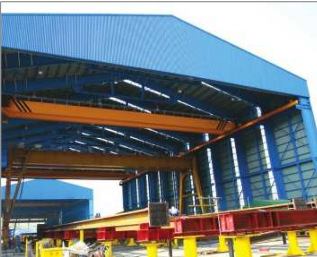
현대중공업 선행의장공장 무빙쉘터 신설공사 (2007, 울산)
