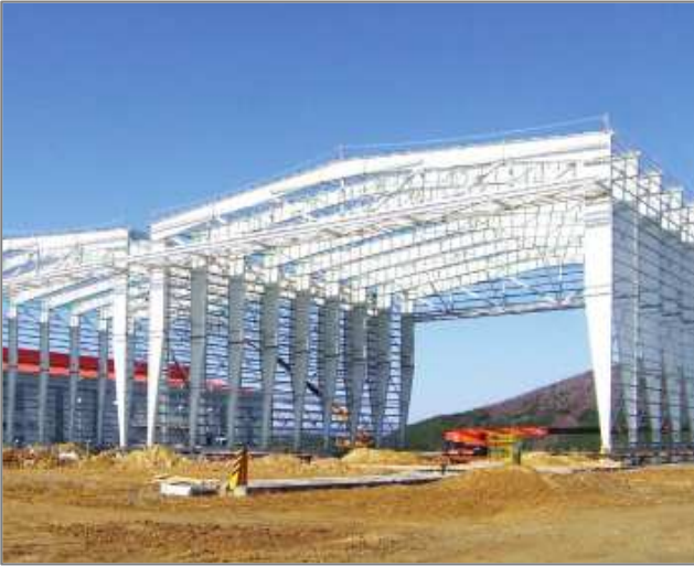
엔케이 포항공장 무빙쉘터 건설공사 (2009, 경북)
